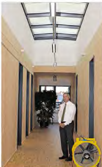
Der große Entlüfter ist ausgeteilt, seit Baufohle die Dachverglasung gegen die ärgste Hitze auf den Gängen im ALE-Neubau abschirmt. Baudirektor Thomas Gollwitzer hofft auf eine baldige Dauerlösung mit Lüftungsmöglichkeiten. Bild: as
