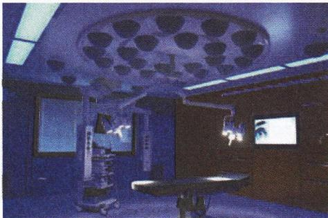
Abb. 1: Beispiel einer Opragon-22 Installation laut DIN 1946-4, 1a in einem OP in der OTH Amberg-Weiden.
