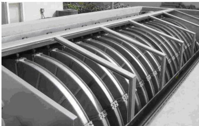
stellen eine Möglichkeit dar, den Anteil ab filterbaren Stoffe zu reduzieren. Allerdings bieten auch moderne, leistungsfähige Siebverfahren eine innovative Lösung, um Feststoffe aus dem gereinigten Abwasser zu entfernen. Kompakter als es ein Sandfilter jemals sein
