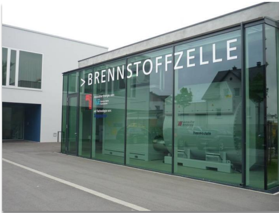
MTU Hot Module 245 kWel / 150 kWth
